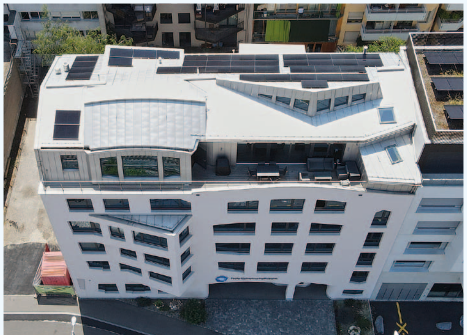
↑ Photovoltaikanlage auf dem rückwärtigen Dach der Freien Gemeinschaftsbank
